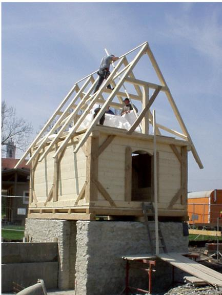
Bild 11 Der Kornspeicher besteht aus einem gemauerten Untergeschoss, einem Fachwerkbau mit Bohlenwänden und einem Sparrendach mit gleichartigen Gebinden.
