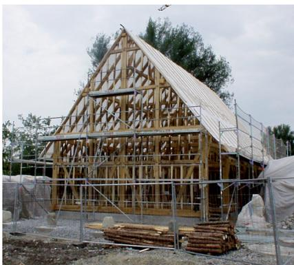
**Bild 4 Die Fachwerkkonstruktion des Bauernhauses besitzt Bundständer und eine Aussteifung über lange Bänder, die über die Wandscheiben hinweggeführt sind (siehe auch Bild 5, Mitte).**
