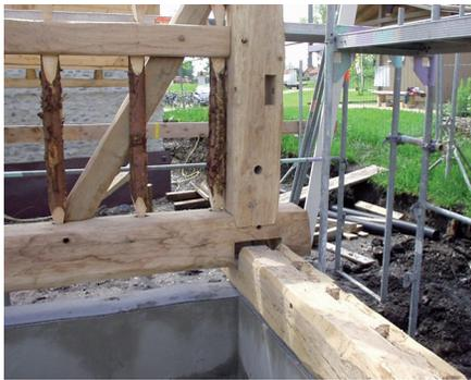
Bild 10 Anschlussdetail eines Wandfachwerks mit einer Schwelle durch Verblattung. Stählerne Verbindungsmittel gibt es keine.
