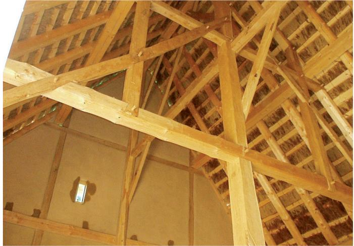
Bild 9 Die giebelseitigen Gebäudebereiche der Scheune sind bis ins Dach offen ausgeführt, da sie als Lagerräume dienen.
