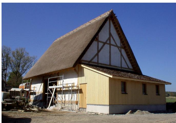
**Bild 6 Die Scheune folgt demselben Konstruktionschema wie das Bauernhaus. In der Mitte des dreizonigen Baus liegt die über ein großes Tor erschlossene Tenne (links im Bild).**
