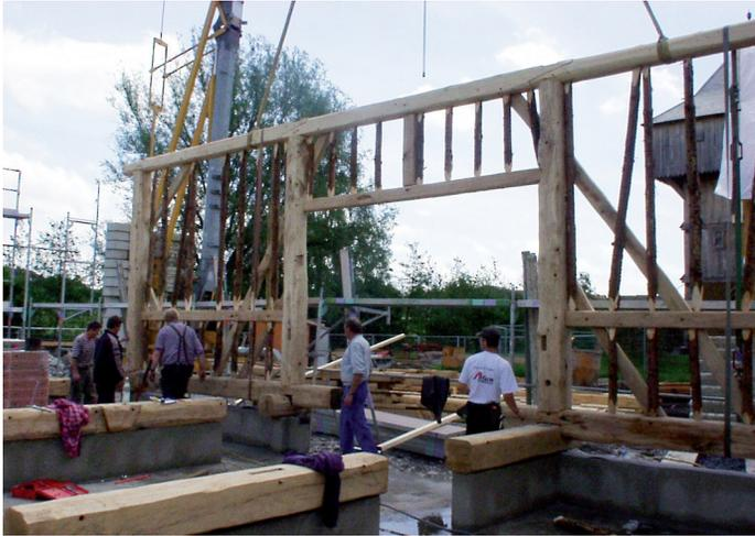
Bild 8 Die rekonstruierten Fachwerk-Wandelemente der Gebäudelängsseiten der Scheune wurden komplett vorbereitet, per Kran eingehoben und an die Fundamentkronen angeschlossen.
