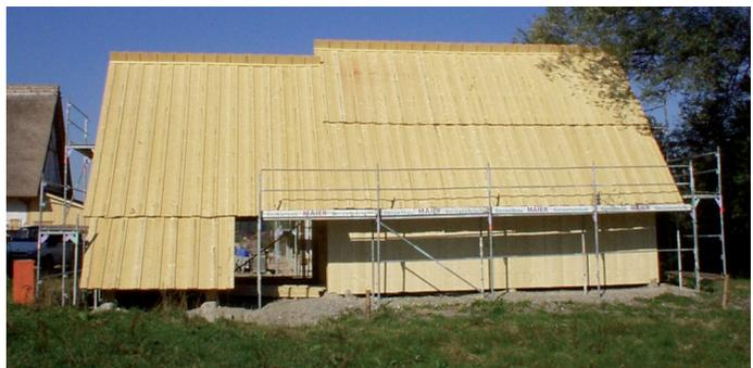
Bild 13 ... ist mit einer Bretterdeckung aus Nadelholz versehen, ebenso die Wände.
