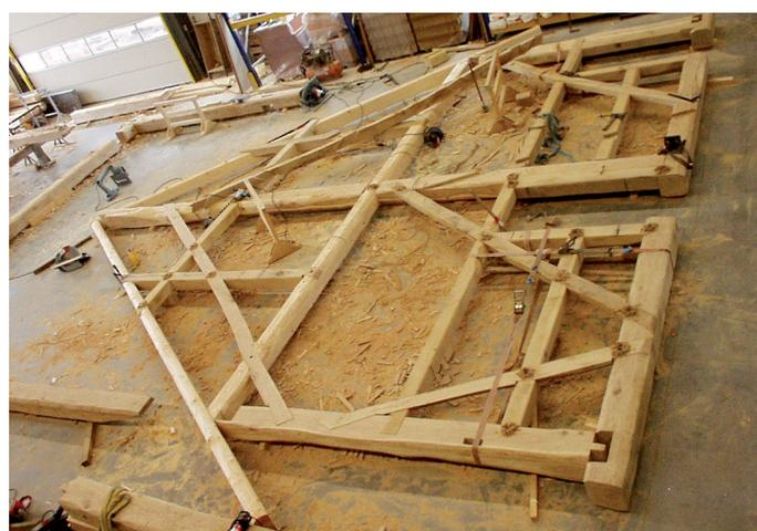
**Bild 7 Ein Querbund der Scheune beim Zusammenbau in der Werkstatt. In der Mitte befindet sich der Firstständer.**
