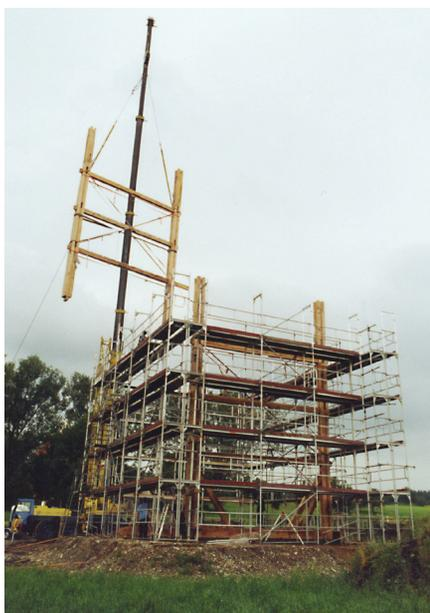
**Bild 4** Zur Montage und Justierung der Bauteile war ein umlaufendes Gerüst erforderlich, das auch zur Abstützung eingesetzt wurde solange die aussteifenden Bauteile noch fehlten.
