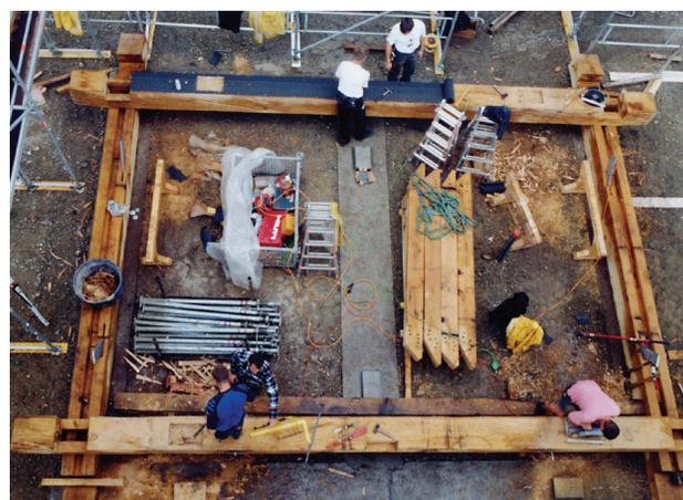
**Bild 5** Justierung der Basisbalken, deren Eckverbindungen als Verkämmung mit Vorholz ausgeführt wurden. Die Löcher nehmen die Zapfen der Bundständer auf (siehe auch Bild 3). Die Nutungen für die Bohlenwände sind ebenfalls vorbereitet.
