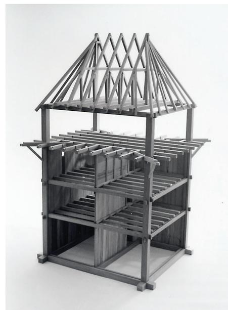
**Bild 7** Das noch unfertige Modell des Wohnturmes zeigt die Tragkonstruktion der Geschossdecken, der auskragenden Wehrgalerie sowie des Daches noch ohne Aufschieblinge (siehe auch Bild 8).
